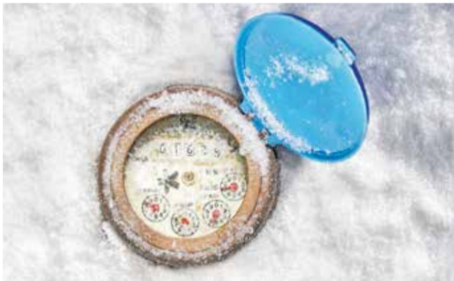
Posledice nizkih zimskih temperatur se kažejo tudi na pogosto poškodovanih vodomernih. / FOTO: KOMUNALA KRANJ
